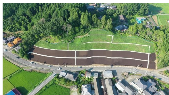
写真-5 工事完了後(1)
