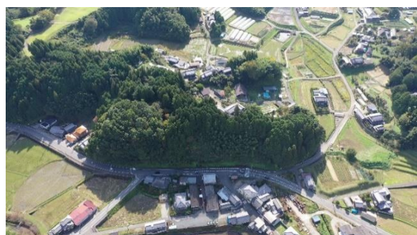
写真-4 工事着手前(1)
