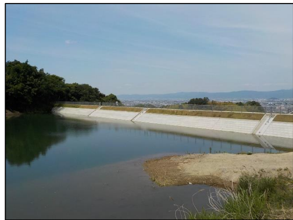
写真-2 上新池（R3 工事完了時）
