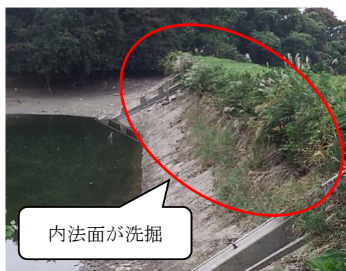
写真-1 上新池上流部 (改修前)
