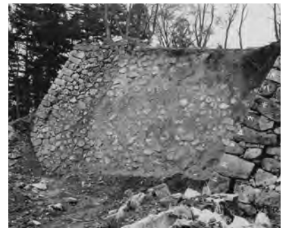
新櫓の石垣復旧状況
