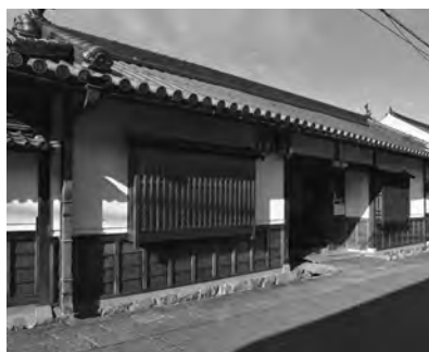
2. 移築された下屋敷表門
