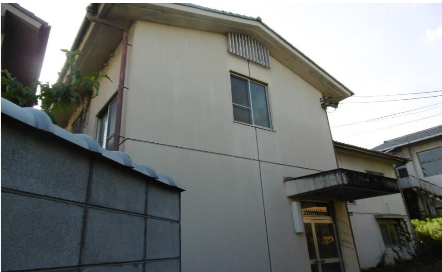
敷地内南側より撮影
