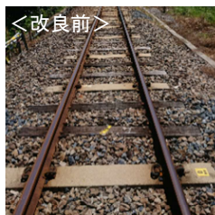
JR和歌山線 軌道の現状(最高時速85km)
