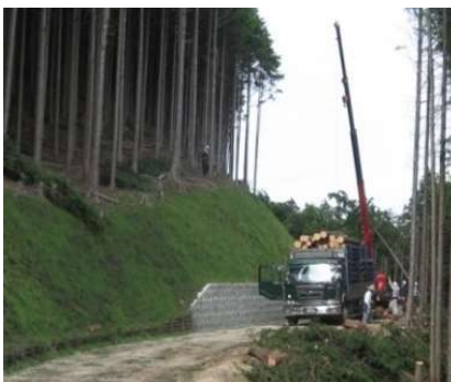
林道を活用したトラックによる木材の搬出
