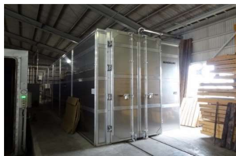
品質向上のための乾燥施設整備
