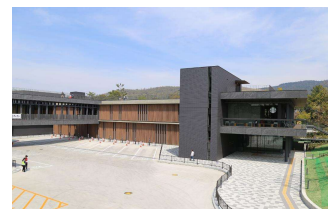
公共建築物の木造・木質化 (奈良公園バスターミナル)
