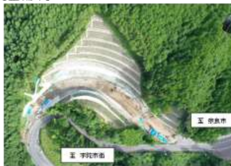
線形改良区間[令和4年度 完成供用予定]
