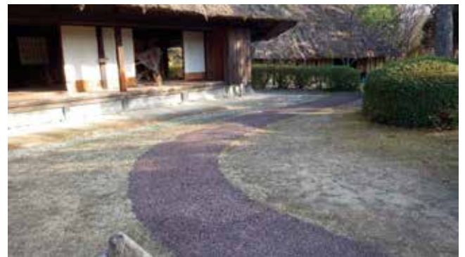
図9 施工4年経過の半炭化処理木質舗装（上：舗装A、下：舗装B 撮影日：2021/2/11）
