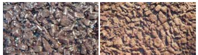
図10 施工4年経過の半炭化処理木質舗装路面（左：日なた、右：日陰 撮影日：2021/2/11）
