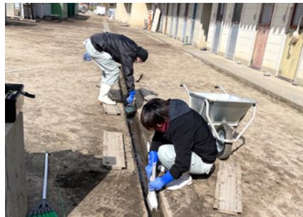
溝の泥あげ作業
