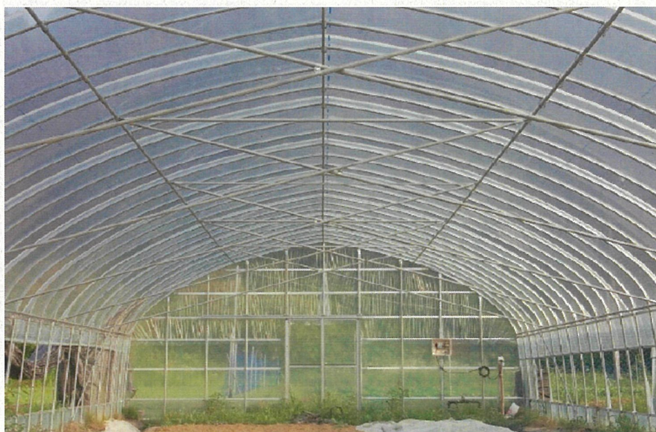
クロスバーによる補強 (大和野菜研究センター内に設置)
