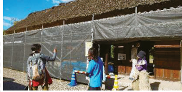
民俗博物館古民家修理現場公開
