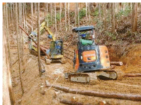
整備中の奈良型作業道
