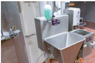
自動手洗いの設置
