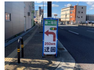
図5. 迂回誘導看板
