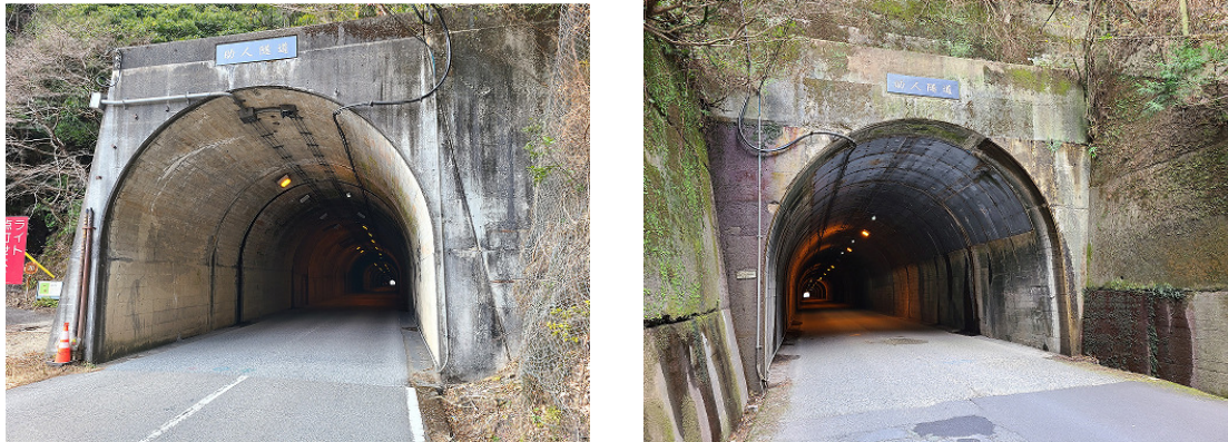
写真1 助人トンネルの坑口（左：新宮側 右：五條側）
