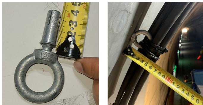
写真6 アイボルト及び結束バンドの固定状況
