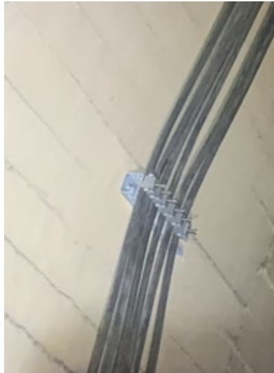
写真7 ケーブラーの固定状況
