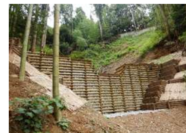
谷止工(公共事業への間伐材利用)
