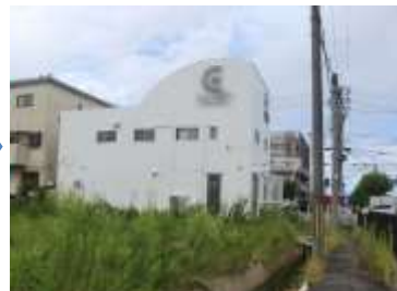
撤去後（H30.8撮影）
