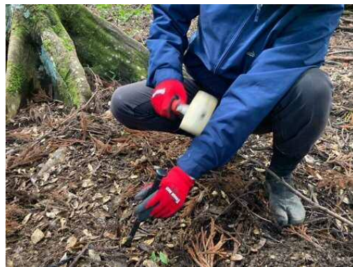
図2 保守作業の様子 (例・アンカー杭の打ち直し)
