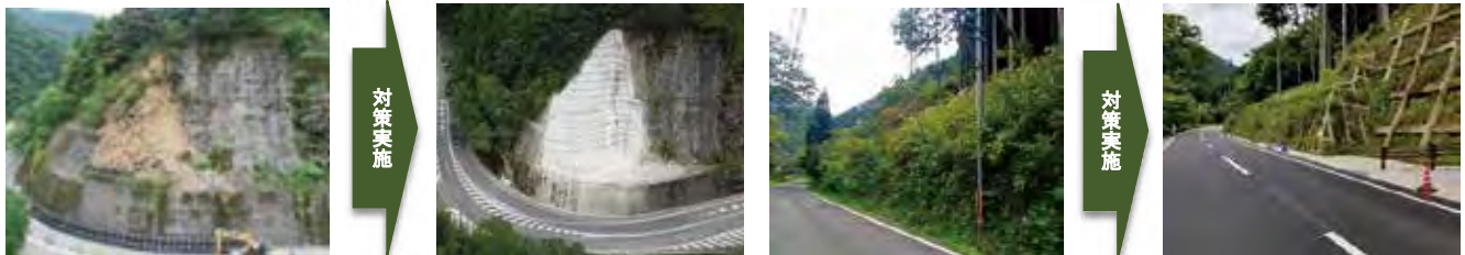
▲法面对策（国道168号 十津川村野尻）
