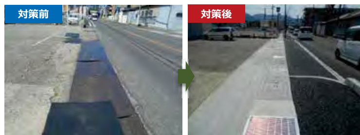
▲歩道設置（国道166号 葛城市尺土）
