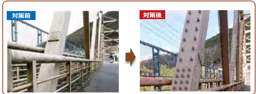
▲当て板補強による補修工事
