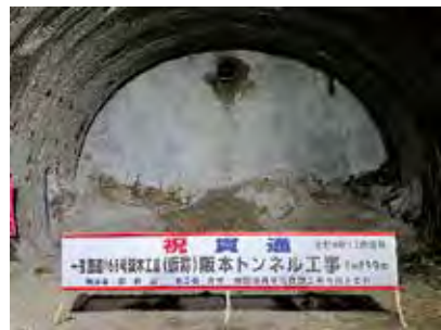
▲トンネル貫通（令和4年12月）
