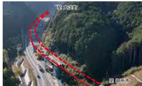
▲工事のようす
