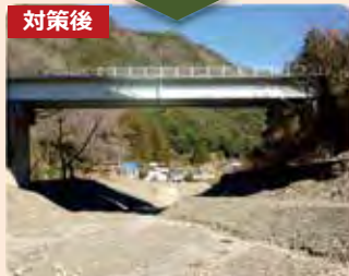
▲ 橋梁の補修工事 (国道168号河津橋)
