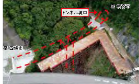
▲工事のようす
