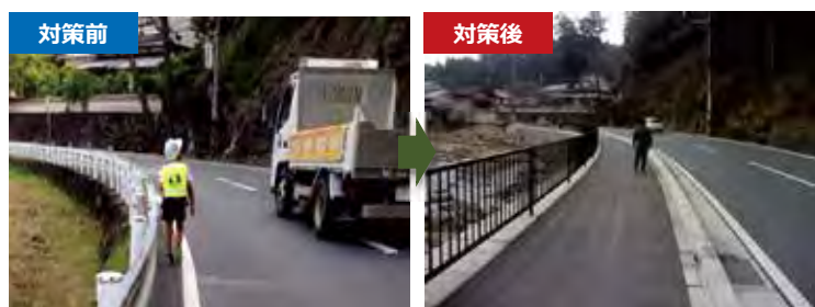
▲歩道設置（国道369号 宇陀市榛原檜牧）
