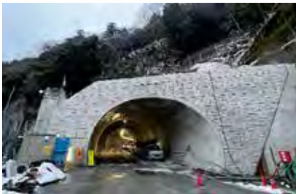
▲工事のようす
