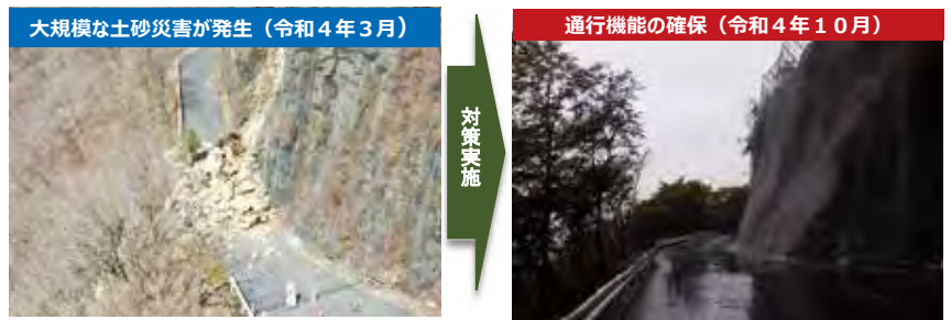
▲法面对策による通行機能の確保（国道309号 天川村北角）
