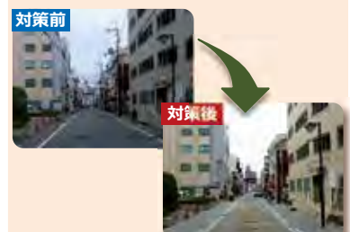
▲無電柱化 (県道大和八木停車場線)
