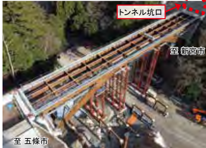
▲工事のようす
