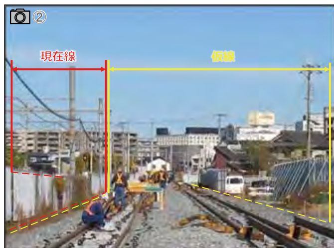
▲ 南大安寺踏切付近 (仮線路工事)
