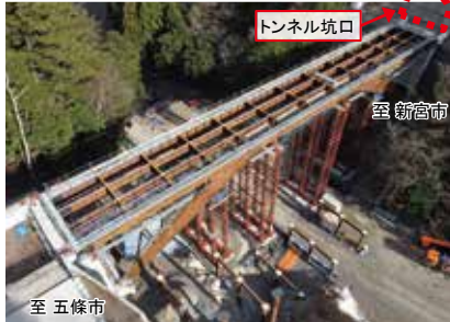
▲工事のようす
