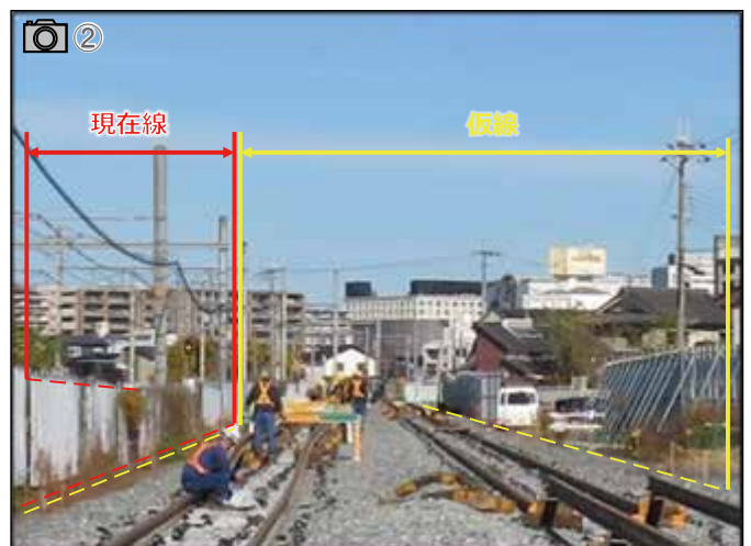
▲ 南大安寺踏切付近 (仮線路工事)
