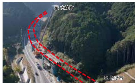
▲工事のようす
