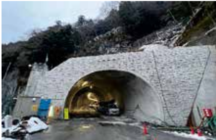
▲工事のようす
