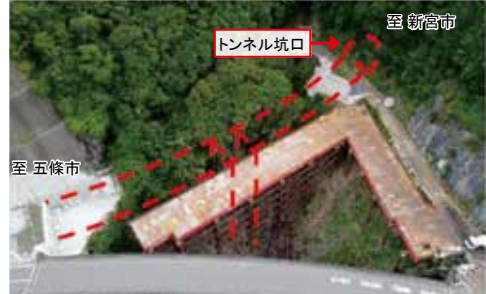
▲工事のようす
