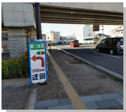
図 6-16 迂回誘導看板の設置
