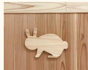
■NC加工で製造した遊び心のある無垢の造作
