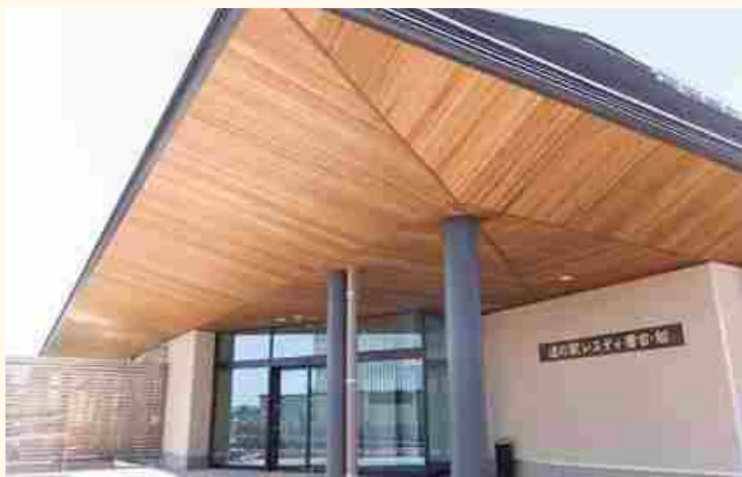
■軒天井施工例
