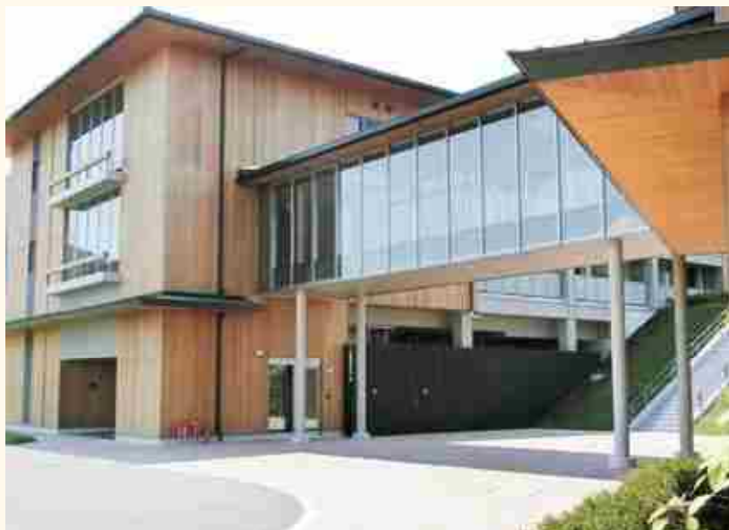
■外壁、ルーバー施工例
