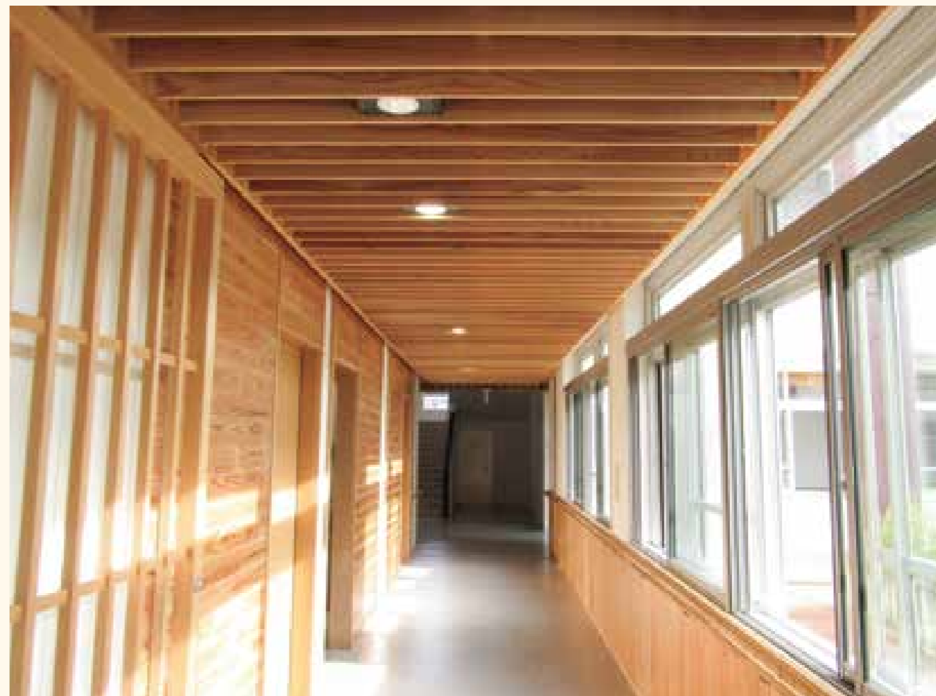
■巾木や窓枠他、全ての造作に杉の無垢材を使用した庁舎
