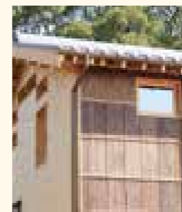
■吉野杉の杉皮です。外壁や内装材として使用いただいています。屋根皮と槍鉋で仕上げた化粧皮を出荷しています。
