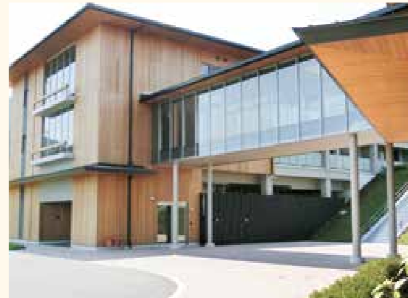
■外壁、ルーバー施工例
