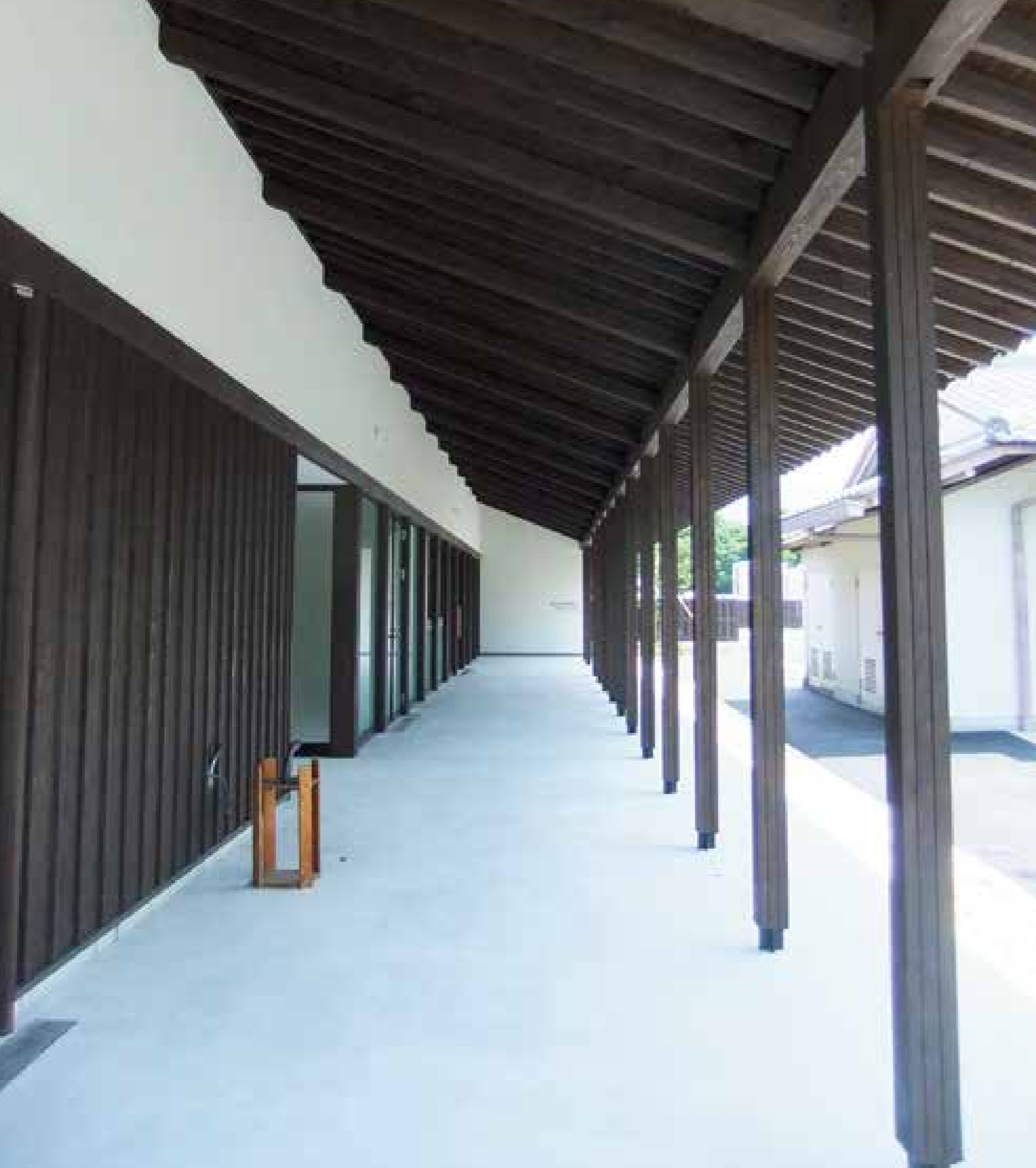
■公共物件 外部化粧柱 (ピン工法)
