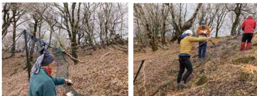
防鹿柵の設置・修繕作業
