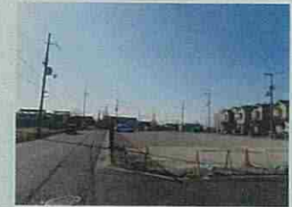
骨格幹線道路用地買収の状況 (都市計画道路(西九条佐保線)の道路整備)
