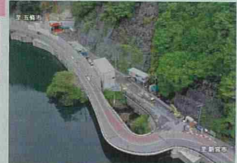
阪本工区・(仮称)阪本トンネル(トンネル工事)
