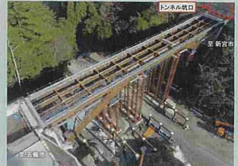
長殿道路2号橋(橋梁上部工事)
