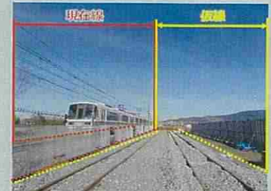
JR関西本線高架(仮線工事)
