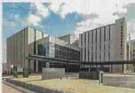
新奈良県総合医療センター
