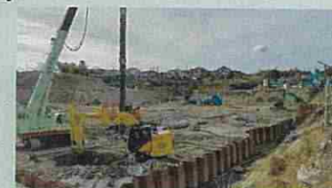
除却工事の進捗状況(R4.12)
