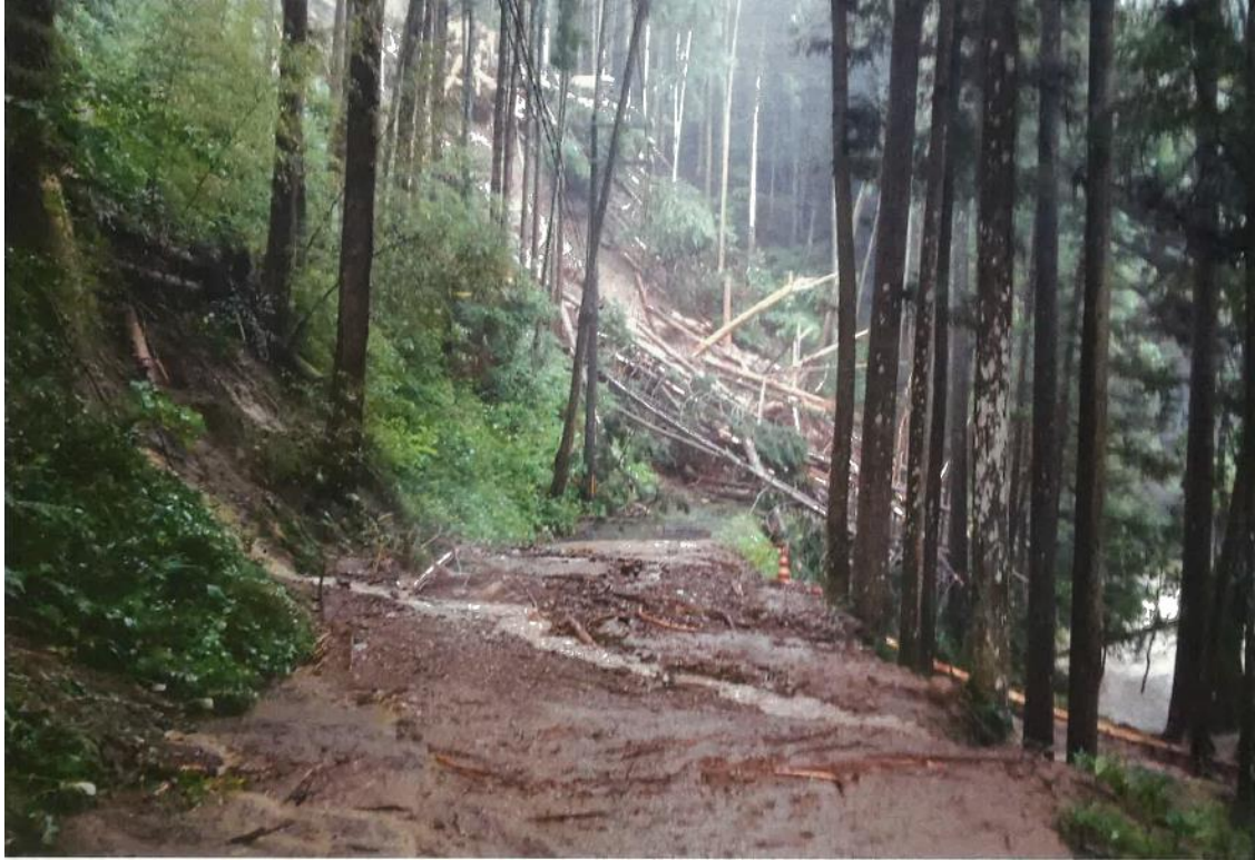
①赤滝五條線崩土現場写真
