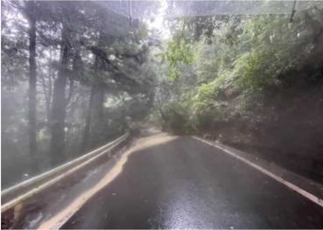
⑮国道310号崩土現場写真
