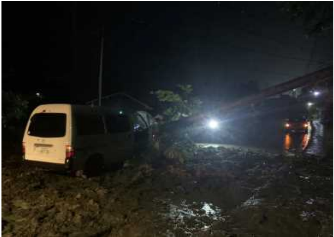
①9国道169号崩土現場写真
