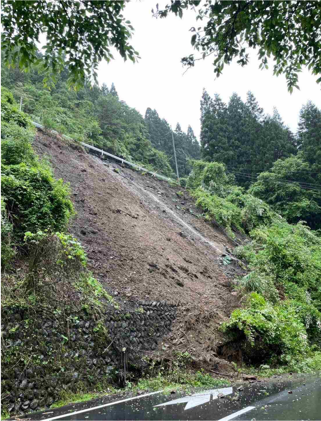
①R168 崩土現場写真
