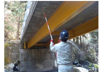
橋梁の点検診断・補修工事
