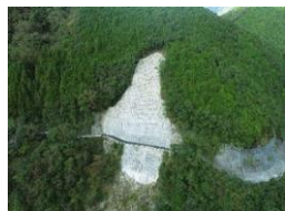
道路斜面の崩壊対策
