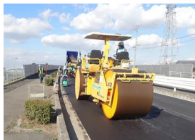
舗装補修工事の状況
