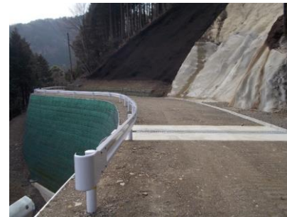
路側擁壁・路盤等の局所改良
