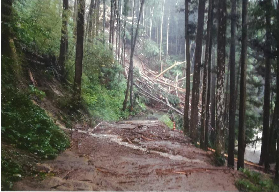
①赤滝五條線崩土現場写真
