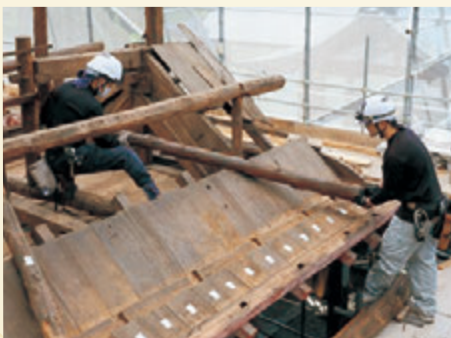
解体した部材は「なら歴史芸術文化村」で修理します。
