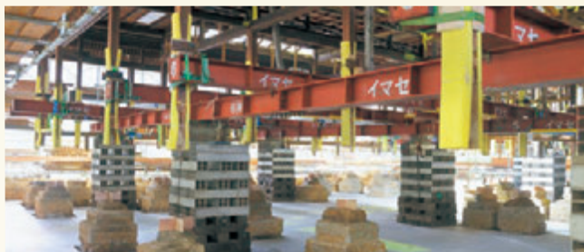
揚前工事（ジャッキで1m持ち上げた状態）
