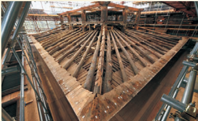
初重屋根の解体状況(令和5年4月末時点)
