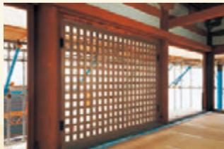
礼堂の耐震補強が必要な箇所面に格子の構造壁をはめ込みました。
