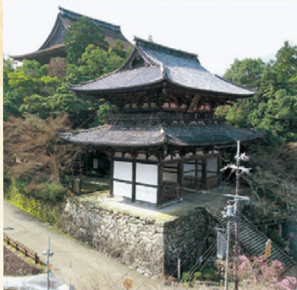
修理前全景(二王門斜め前から)
