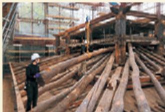
はねぎ「栴木」という屋根の軒先を支える部材を解体している様子
