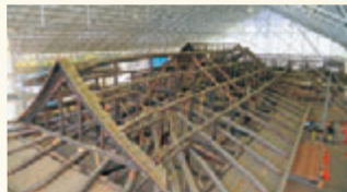
屋根も傷んでいたため、葺替を行います。揚前工事のためにも、骨組みの状態にし、軽くしました。
