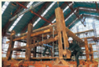
こやつか「小屋束」という部材を解体している様子
