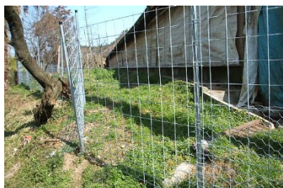
＜野生動物進入防止フェンス＞
