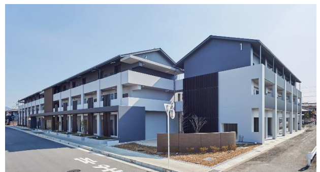
【第1期住棟完成写真 北西方向から撮影】
