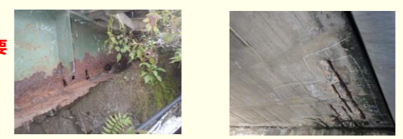
＜主桁腐食＞ 国道165号(吸原橋) ＜床版鉄筋露出＞ 県道大和郡山上三橋線(極楽橋)
