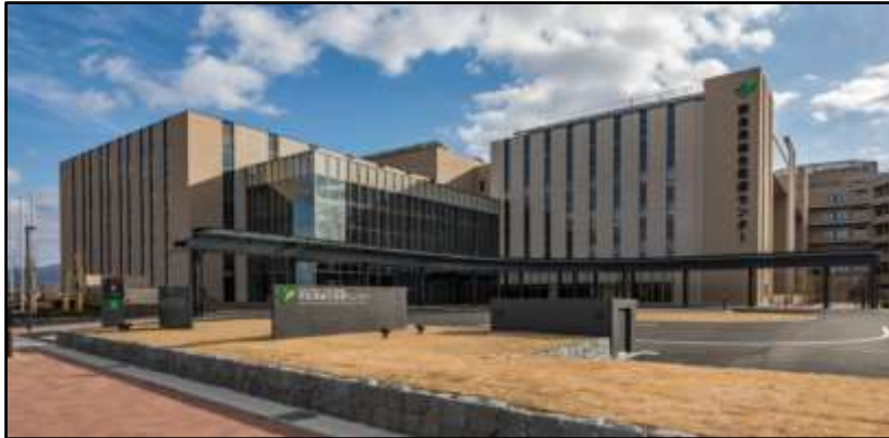
奈良県総合医療センター
