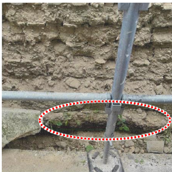
写真5. 土塀基礎石積下の土の部分
