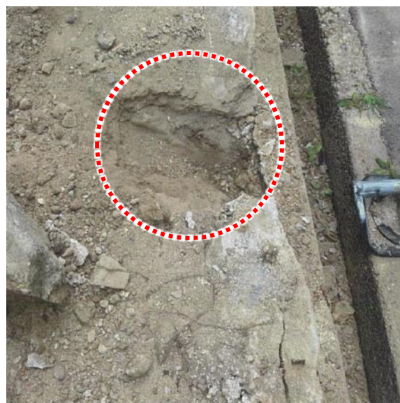
写真6. 石積みの裏込めの確認
