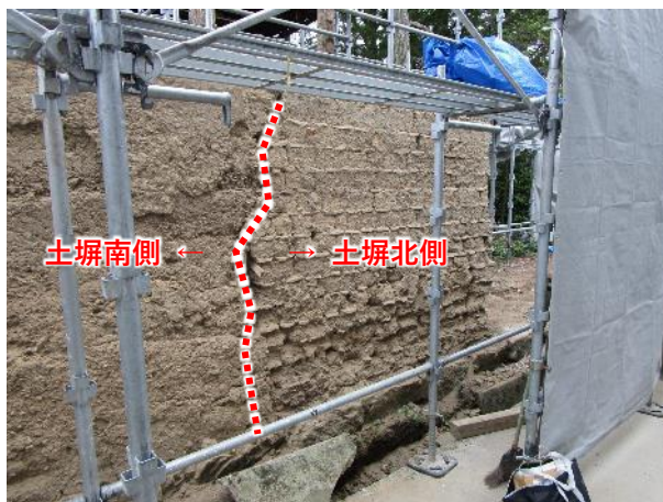
写真 3. 太鼓塀内部土塀東側
