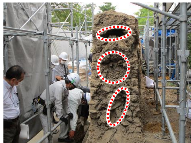
写真 4. 土塀北側断面
