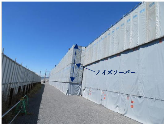
写真-4 追加対策後の防音対策状況
