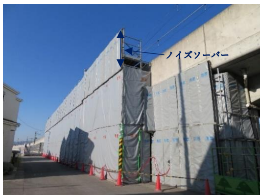
写真-3 夜間試験施工での防音対策
