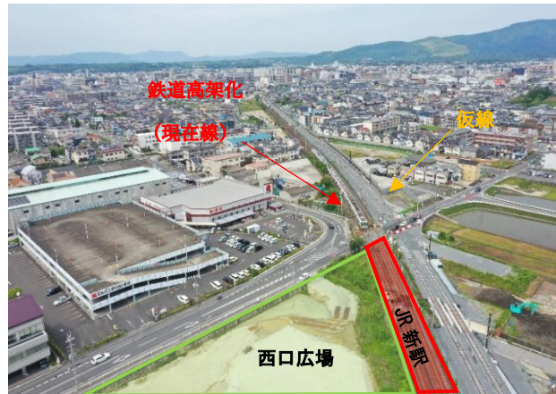
写真-1 現在の施工状況（八条踏切付近）
