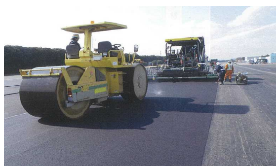
アスファルト合材の敷設
