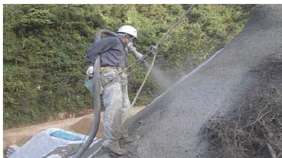
専用機材でモルタルを吹付
