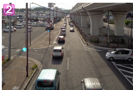
側道部(大阪行き) 片側2車線
