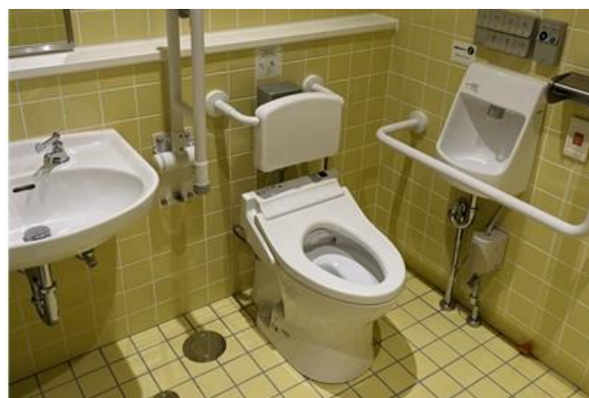
多目的トイレ (車庫棟)
