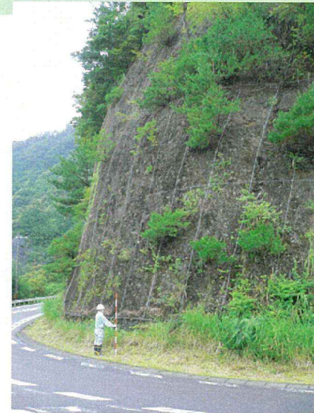
P-8 中央付近の法面状況 露岩部にはロックネット設置されている
