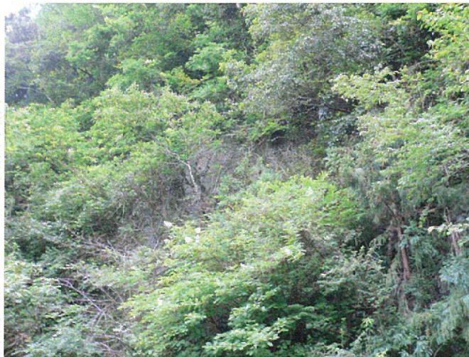
P-6 上部斜面は樹木繁茂している
