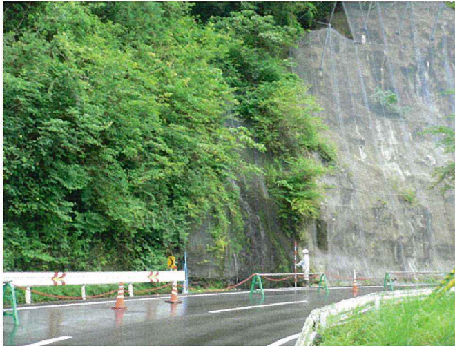
P-13 終点側の沢部には流水あり
