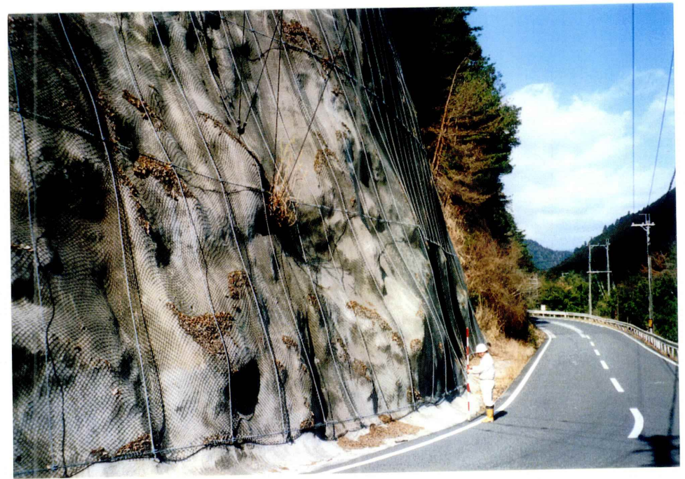
②区間中央より始点側を望む
