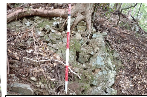
⑬泥岩砂岩互層の露頭状況
