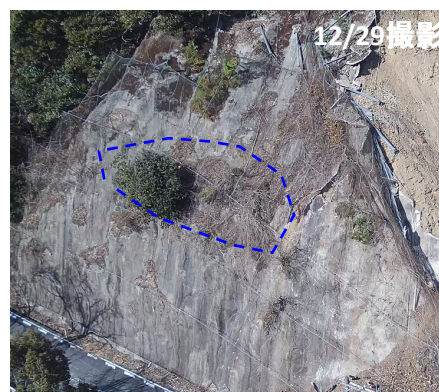
写真⑤ モルタル吹付の緩斜面
