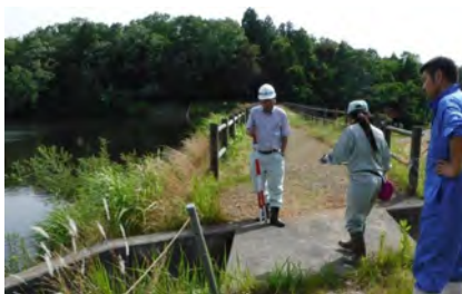
ため池の点検の状況
