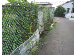
金網による応急措置の状況
