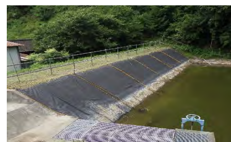
救助ネットの設置状況
