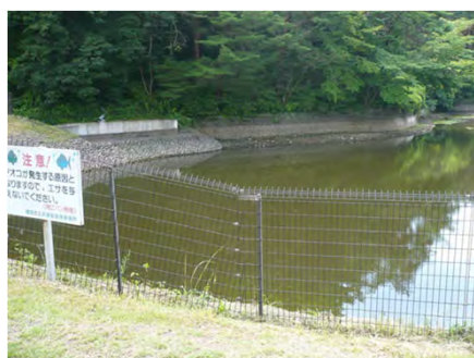
進入防止フェンス、警告看板の設置状況
