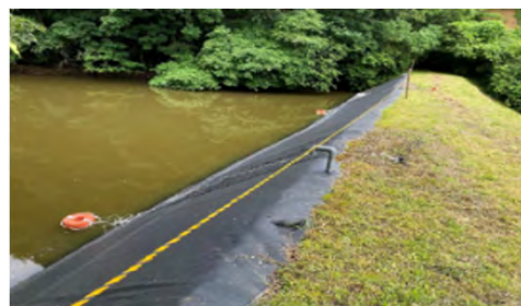
応急処置状況(ロープ、浮輪、救助ネット)
