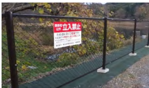
立入禁止看板の設置
