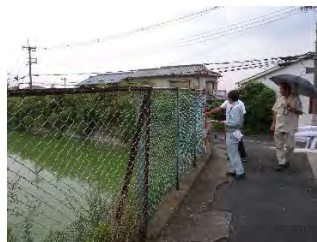
安全柵の点検状況
