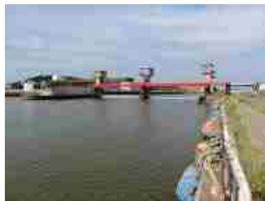
○○自然排水樋門 (○○市○○町○○地内)
