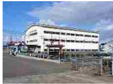
○○排水機場 (○○市○○町○○地内)
