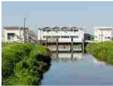
○○排水機場 (○○市○○町○○地内)
