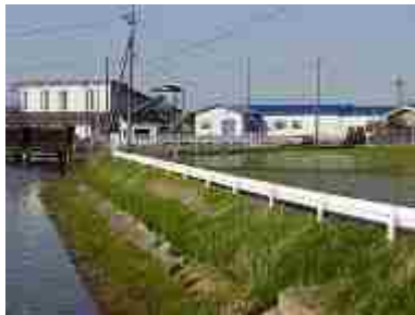
○○排水機場 (○○市○○町○○地内)
