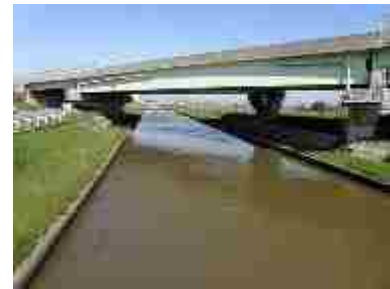
○○排水路 (○○市○○町○○地内)
