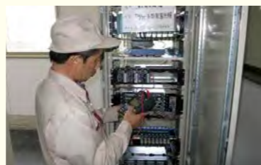
●機械の点検 ポンプ、頭首工、水管理システムや電気類の点検をします。
