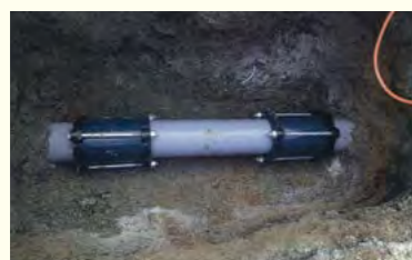
●補修工事 水漏れや壊れているところの修理をします。
