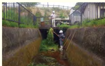
●幹線水路清掃 幹線水路や分水工の中の土砂やゴミを清掃します。
