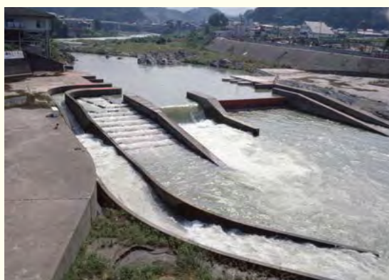
●下淵頭首工 (吉野郡大淀町下淵) 吉野川分水の出発点となる取水口で、川に堰をつくって水を大和平野へと流しています。
