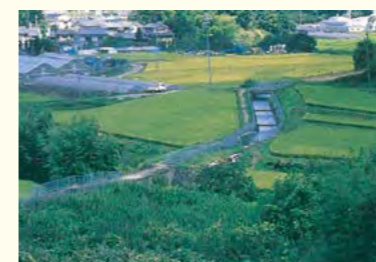
国営東部幹線と高家水路橋 (桜井市)
