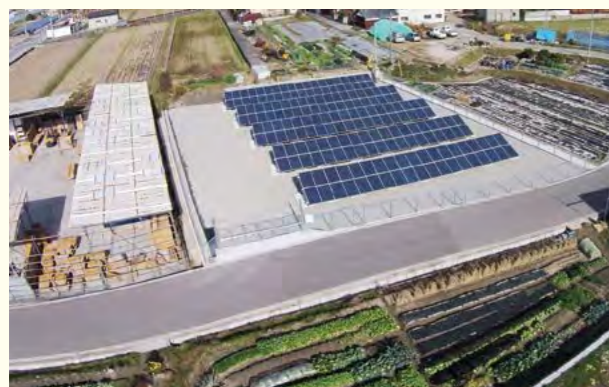
やまのべ発電所 東部幹線水路乙木サイホン (天理市乙木町)
