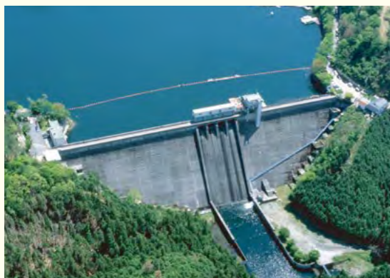
●津風呂ダム (吉野郡吉野町河原屋) 型式:重力式コンクリートダム/堤高:54.3m 堤長:240.0m/有効貯水量:24,600千m 3
