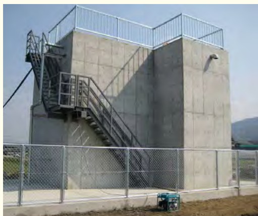
県営初瀬川工区第1号幹線3号分水槽(天理市田町)
