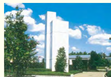
県営北葛城工区3号幹線東支線第7号分水槽 (北葛城郡広陵町)
