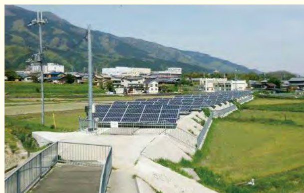
かつらぎ発電所 西部幹線水路10号開渠(御所市西寺田)
