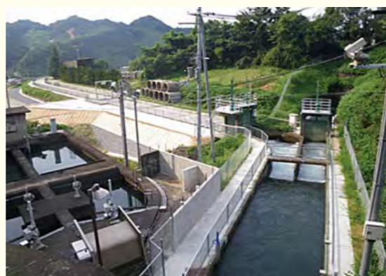
●東西分水工 (御所市樋野) 下淵頭首工から送られてきた水を東西に分岐させる施設。ここで東部幹線水路と西部幹線水路に分かれて大和平野へと送られます。
