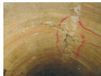
施工前のひび割れの状況
