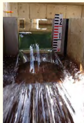
分水槽の内部
