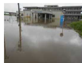
浸水時の状況 (喜多方市提供)
