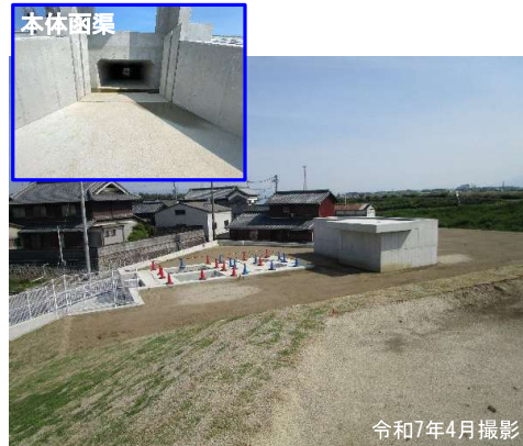
東側内水取込樋門本体 完成写真
