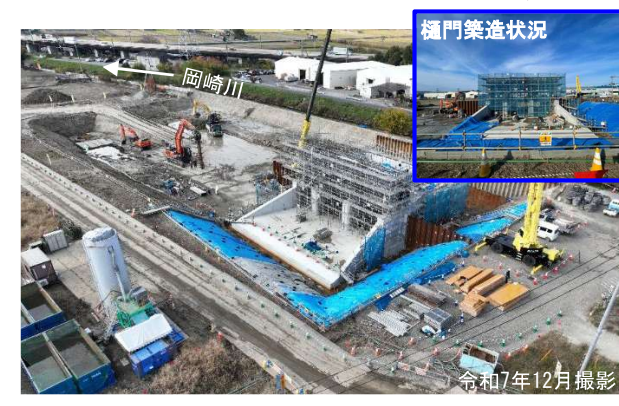
北側内水取込樋門本体 施工状況写真
