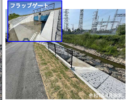
大通井川樋門本体 完成写真
